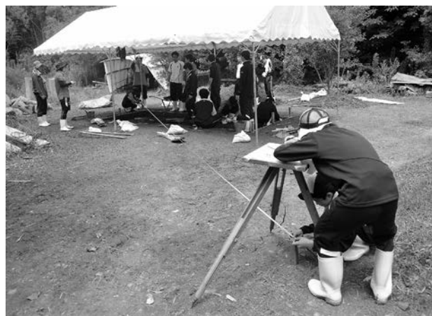
平板実測による測量 R1
