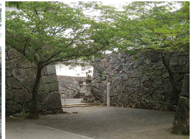
玖島城の虎口。石を加工し、隙間を減らす積み方「打込接」は、野面積よりも高く急な石垣になります。近世城郭によく見られる積み方です。
