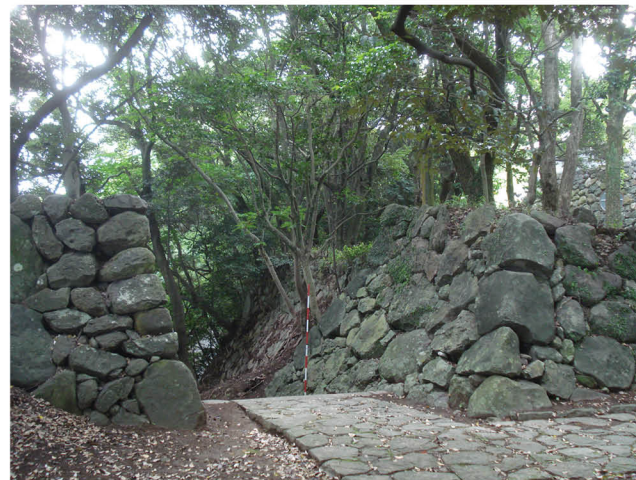
旧大手側にあり、海岸へ続いていたという「いろは段」。両脇に築かれた石垣が「野面積」。築城当初、織豊時代の面影をのこしています。
