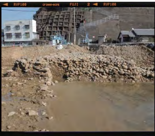
北堤・南堤断面（左が川上側）
