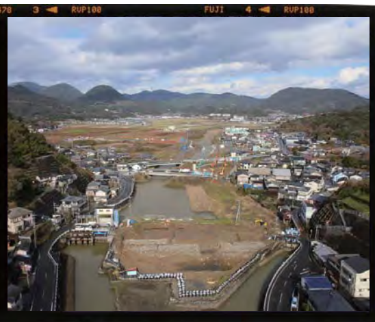
井樋堤塘跡全景（川下側から）
