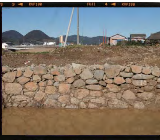
北堤南辺（川下側から）
