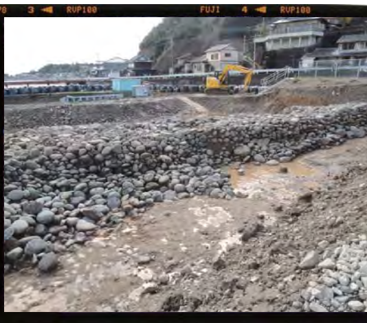
北堤北辺（川上側から）
