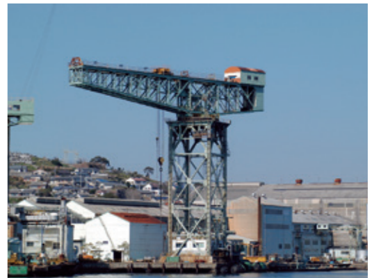
ジャイアント・カンチレバークレーン
